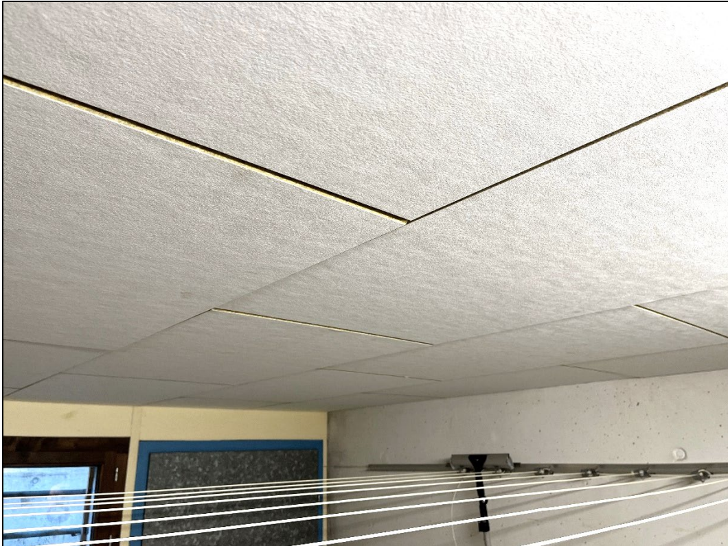
Dämmung der Decke im UG mit Mineralwoll-Dämmplatten
