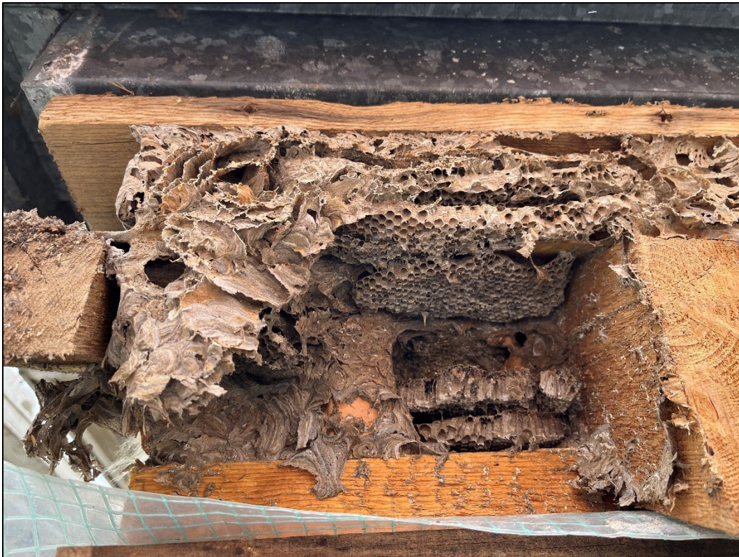
Wespennester und alte Lattungen mit aufgesetzter Dachrinne werden entfernt
