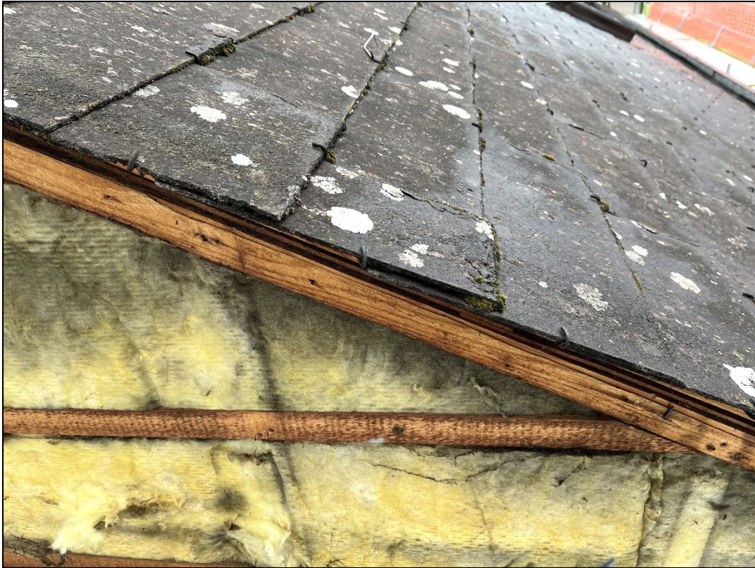
Die alte Eindeckung und die bestehende Dämmung werden rückgebaut
