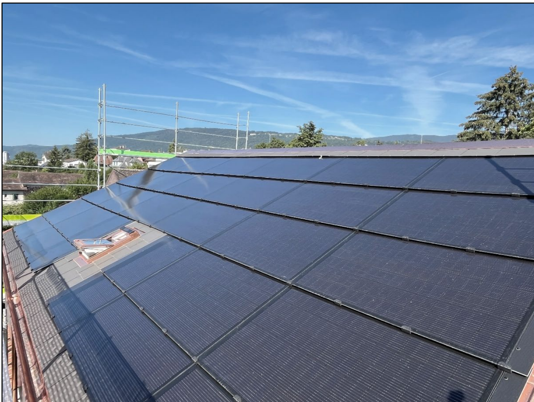
Die Solarmodule sind montiert
