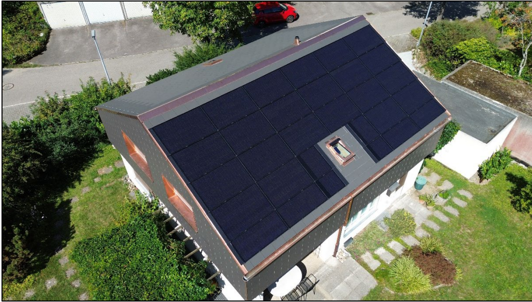
Das neue Dach ist fertiggestellt
