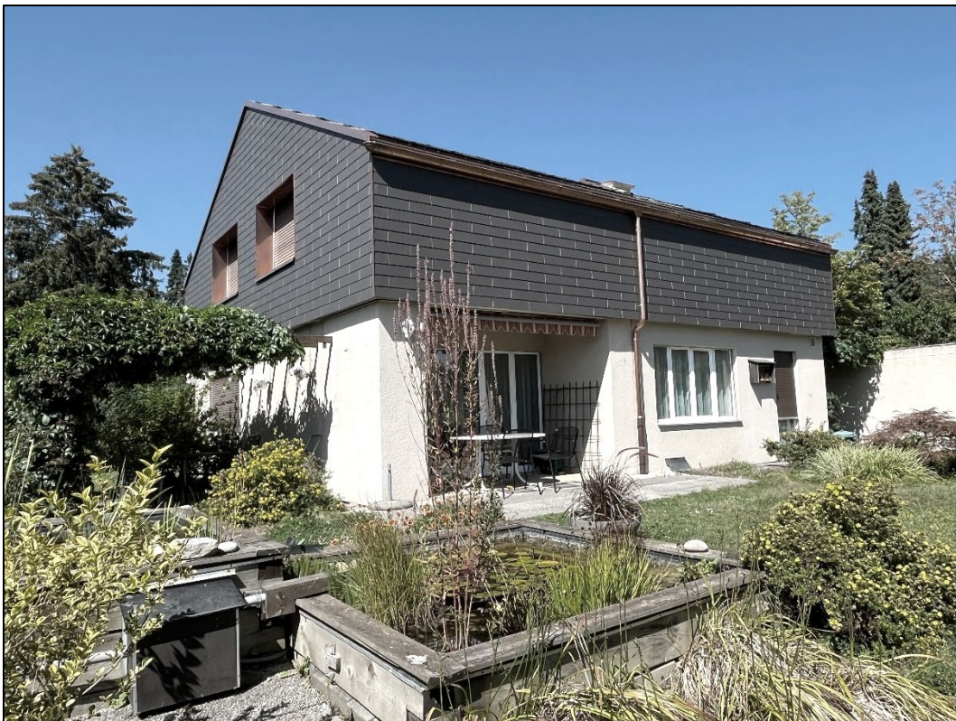
Seitenansicht vom Gebäude mit neuem Dach und hinterlüfteter Fassade vom 1.OG
