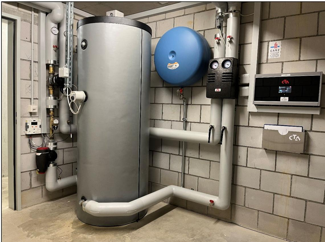
Inneninstallation der Wärmepumpe mit Puffer, Regelung, Wärmemessung
