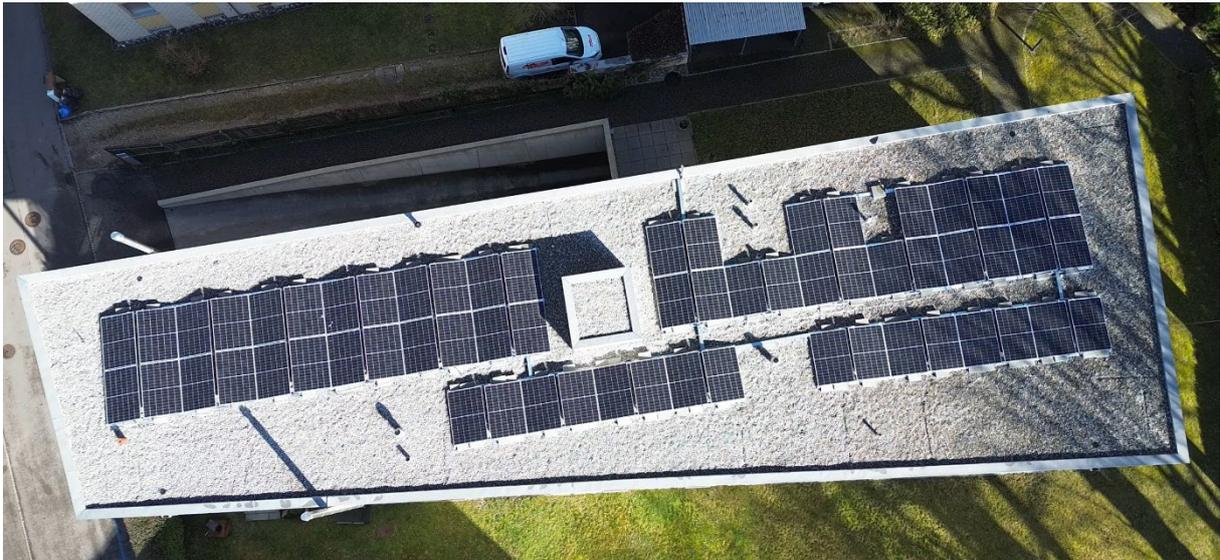
Die fertiggestellte Photovoltaikanlage / Haus 1 - 24 kWp und Haus 2 - 12 kWp
