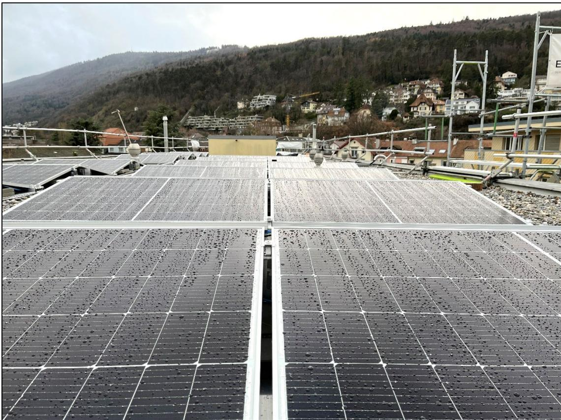
Die PV-Module sind montiert und die Unterkonstruktion gegen Windlast beschwert
