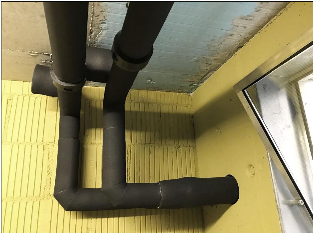
Gebäudeeinführung der Erdsonde mit luftdicht geschlossener Dämmung
