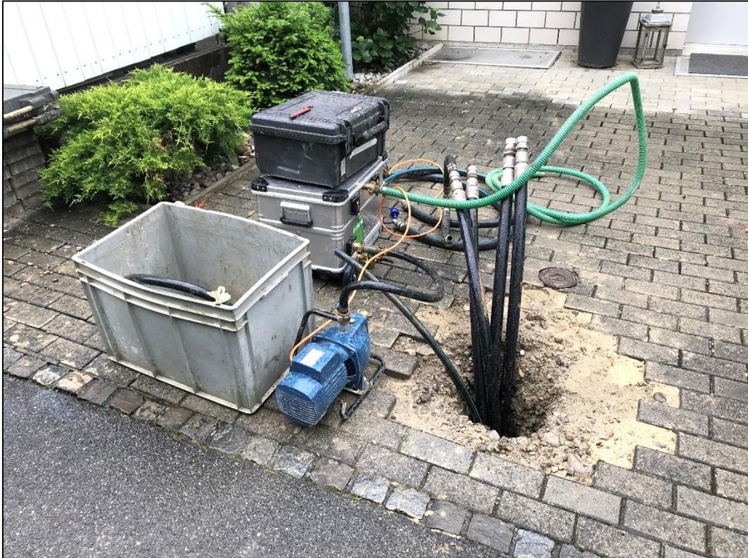
Dichtheitsprüfung der Erdsonde mit Protokollierung. Nach der Gebäudeeinführung ist auf dem Platz keine Installation mehr sichtbar.
