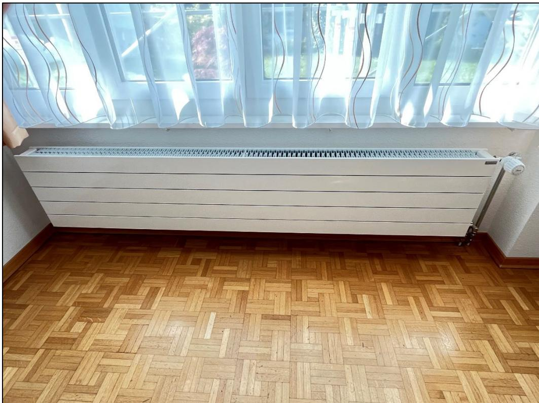
Die neuen Heizkörper mit hoher Abgabeoberfläche und grosser Wärmeleistung für niedrige Vorlauftemperaturen
