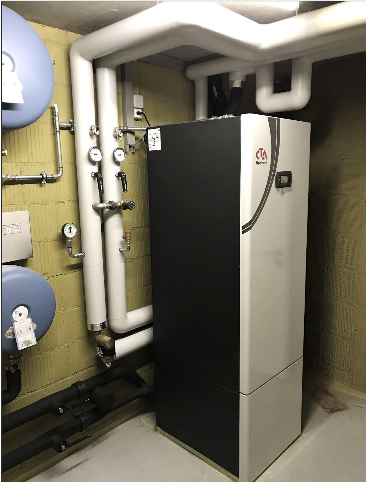
Erdwärme-Wärmepumpe Kombigerät für Heizen mit Warmwasser mit einem Gerät
