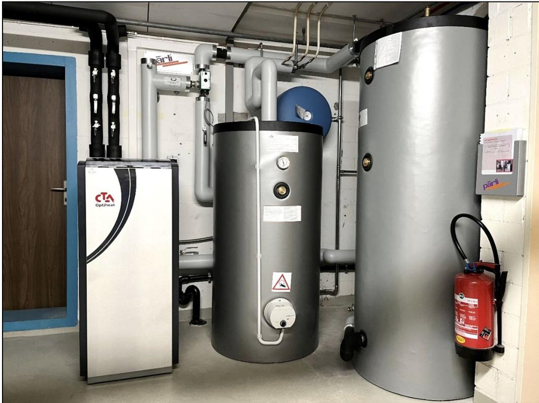
Erdwärme-Wärmepumpe mit Warmwasserspeicher und Puffer (Partnerfirma: Pärli AG)
