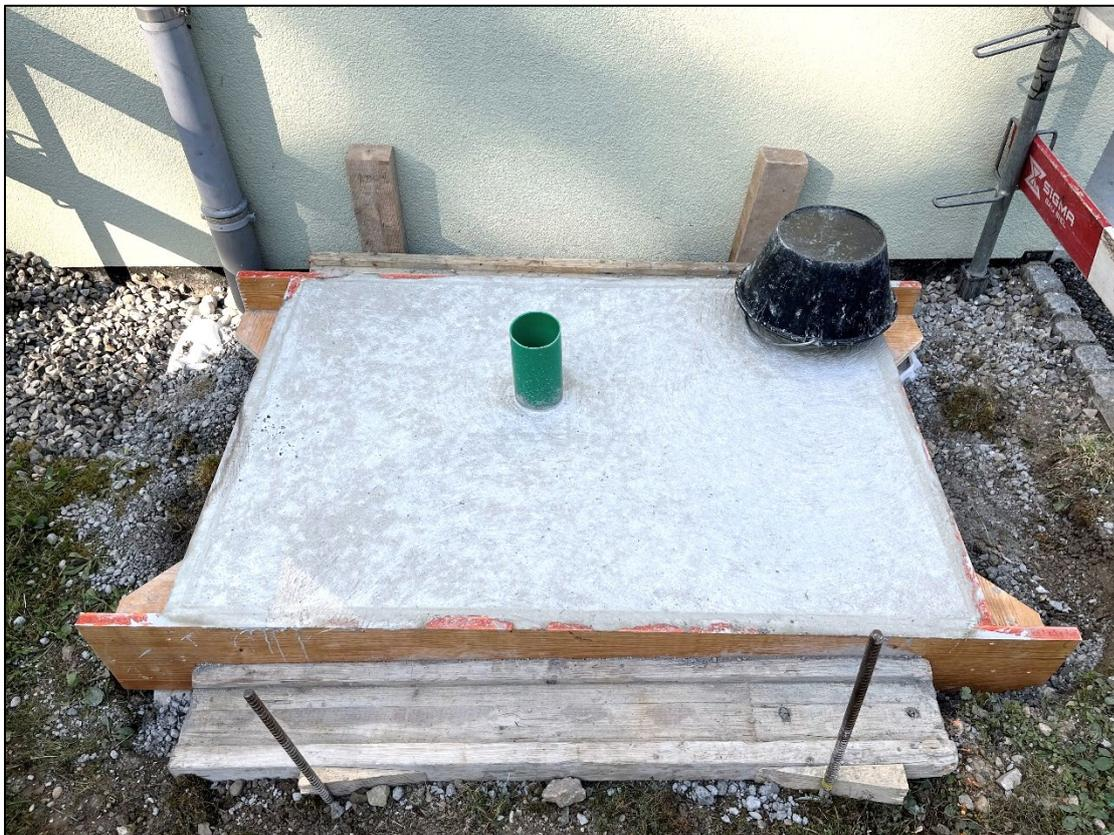
Vorbereitung des Wärmepumpenstandortes mit stabilem Sockel
