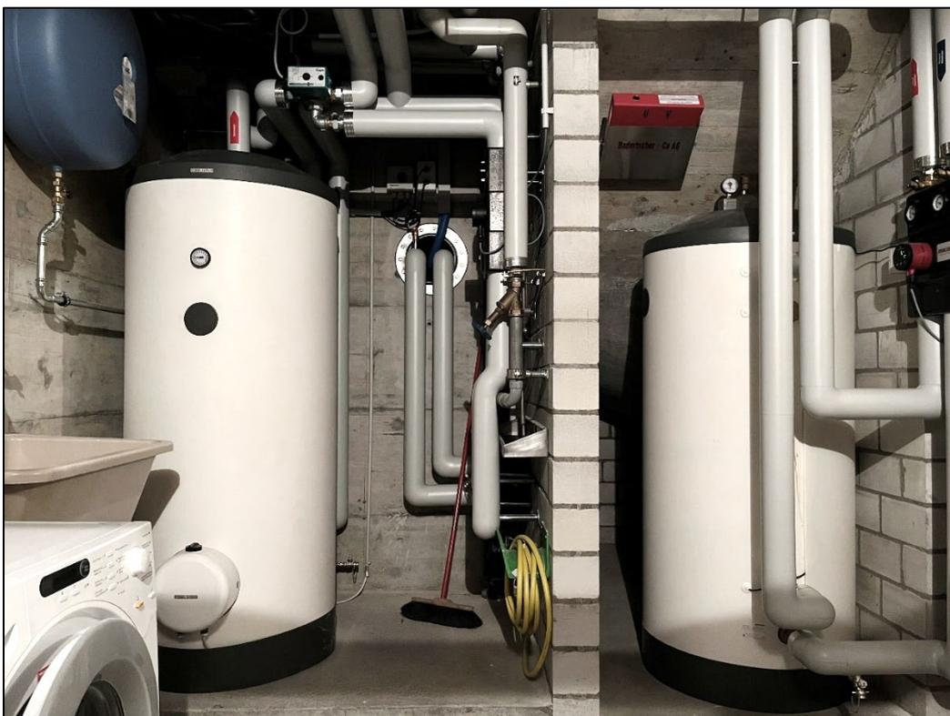
Warmwasserspeicher und Pufferspeicher mit Heizungsverteilung im Untergeschoss
