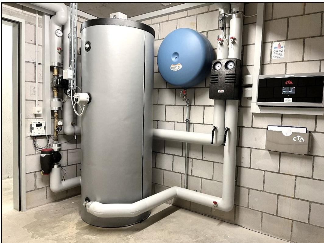
Wärmemessung, Pufferspeicher, Wärmeverteilung, Regelgerät mit Fernzugriff
