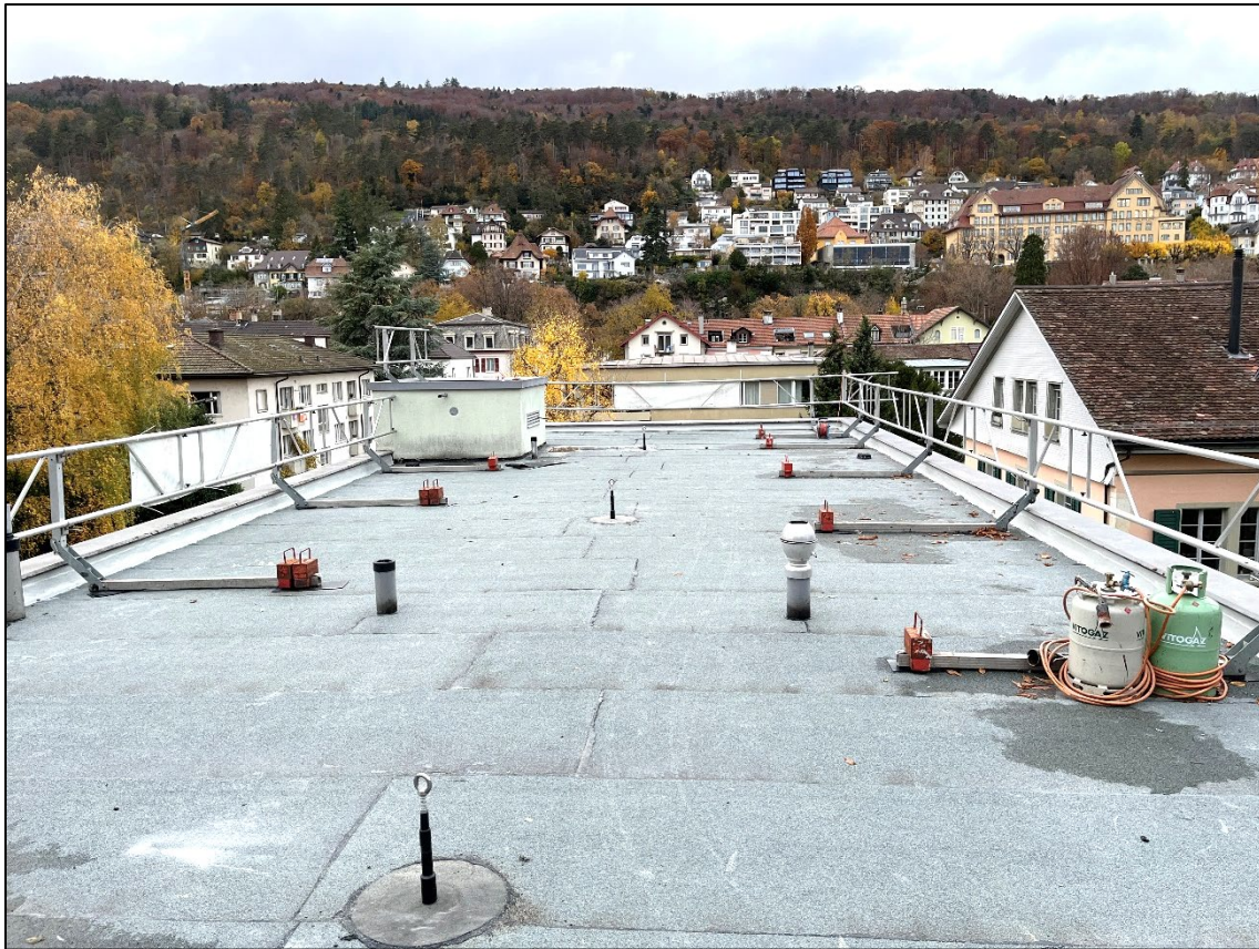
Eine neue Bitumenbahn wird aufgebracht / Absturzsicherungen werden montiert
