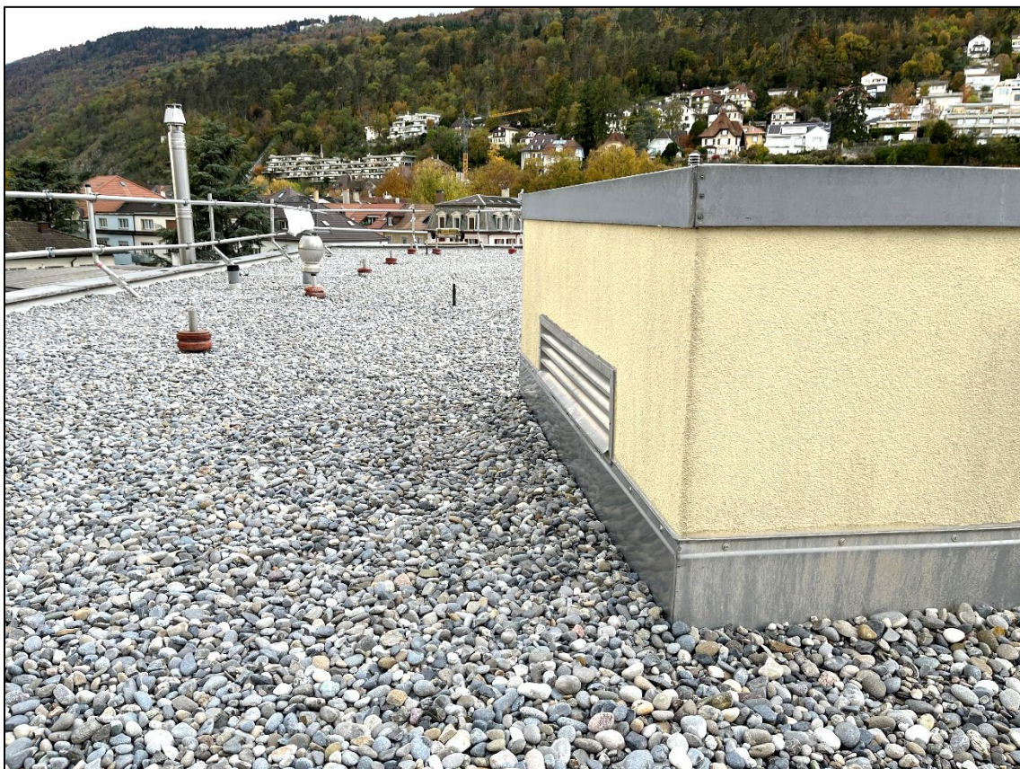
Neue Sockel-Dämmungen und Einfassungen werden beim Liftaufbau realisiert
