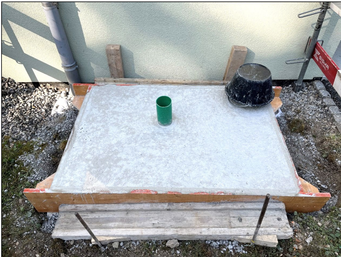
Vorbereitung des Wärmepumpenstandortes mit stabilem Sockel
