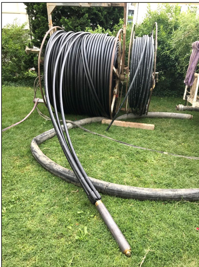
Die Erdsondenleitungen mit Beschwerungskörper
