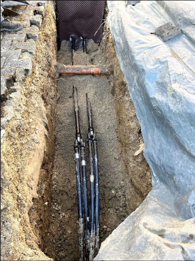
Die Erdsonden beim Garagenvorplatz werden verbunden und ins Gebäude geführt
