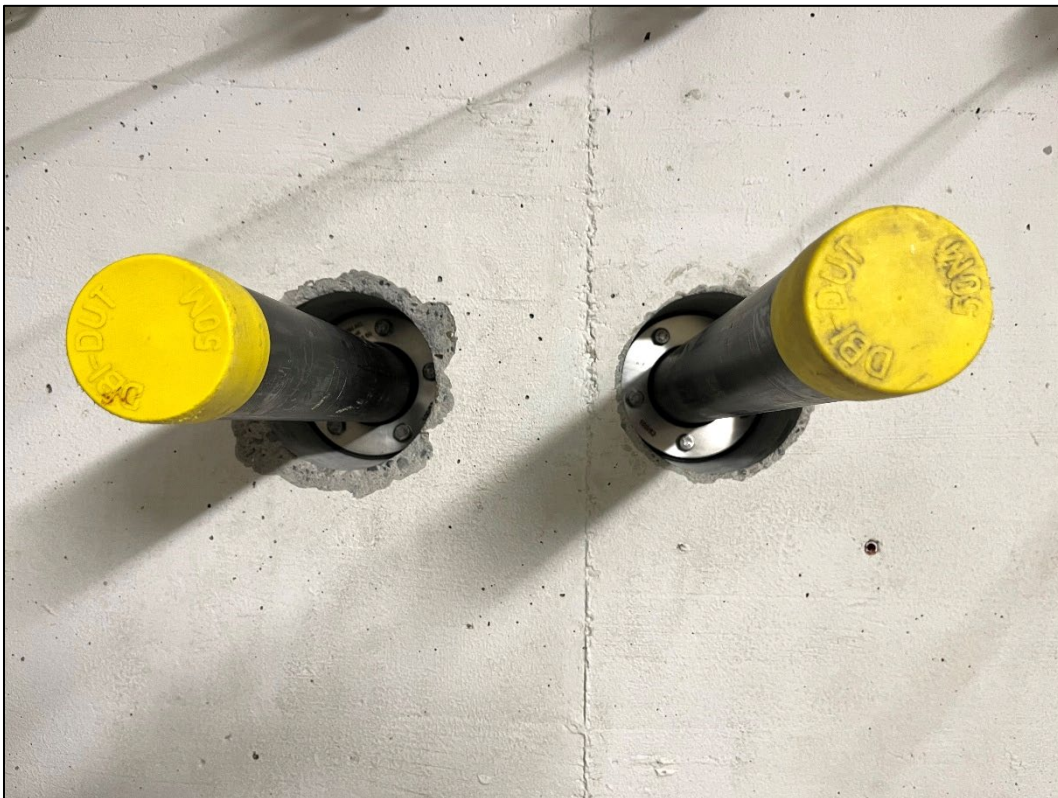
Der Sondeneintritt wird mit Dichtringen in der Aussenwand abgedichtet
