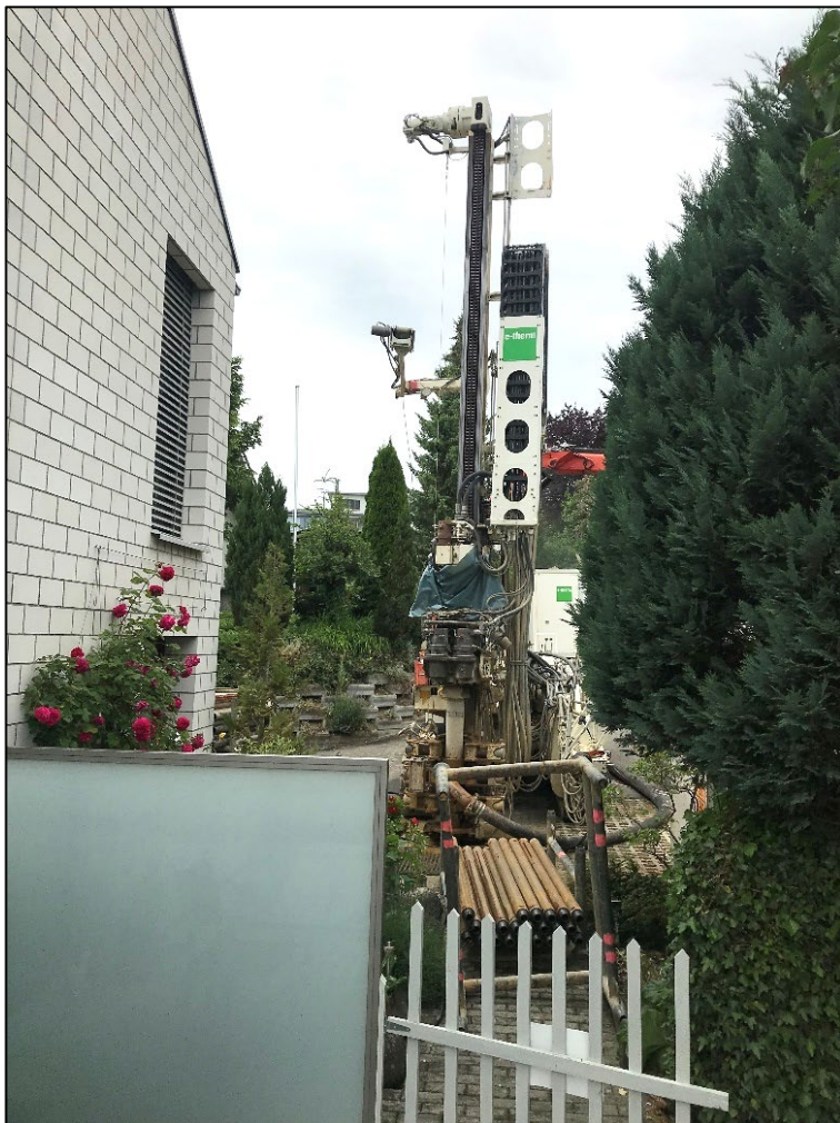
Das Bohrgerät im Einsatz auf dem Autoabstellplatz (Partnerfirma: e-Therm)
