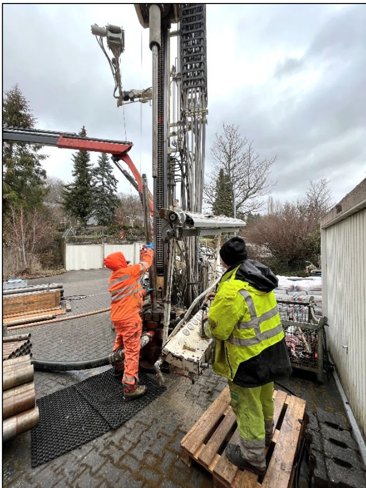
Bohrgerät und Bohrer im Einsatz (Partnerfirma: e-Therm)
